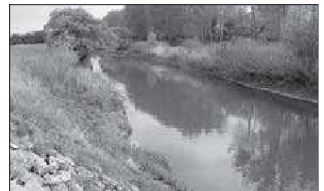
A Hortobágy-Berettyó mederelzáró műleletti szakasza
