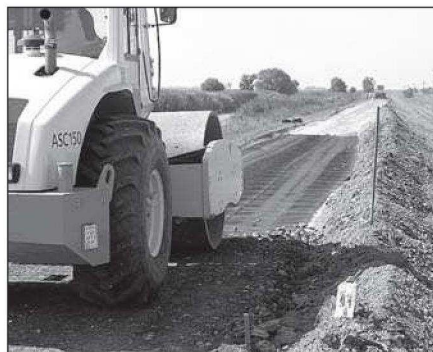
Kövesút építése a Hortobágy-Berettyó töltésén
