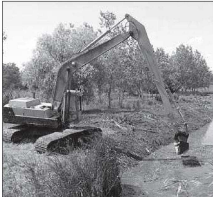
Érfűi belvízcsatorna mederkotrása
