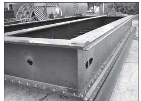
Felújított alvízi ideiglenes elzáró tábla
