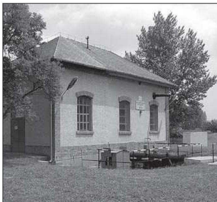
A szivattyútelep 1927-ben épült, tervezője Freytag Ferenc volt
