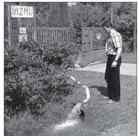
A kútátadás 320 l/p vízhozammal történt meg
